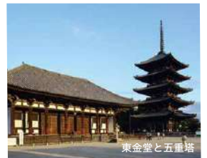
東金堂と五重塔
